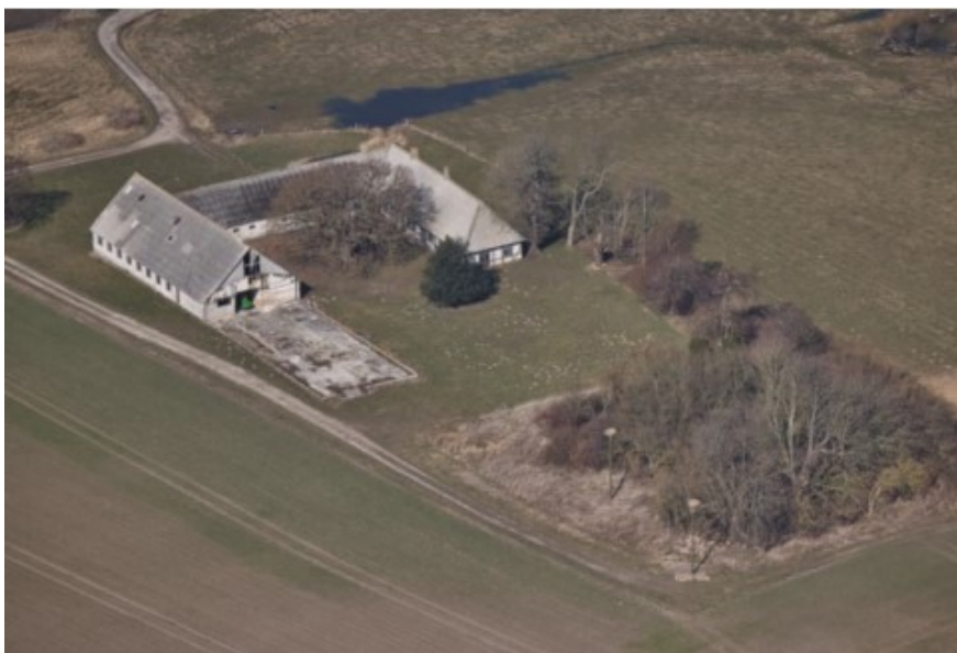
Eksisterende forhold i 2022
