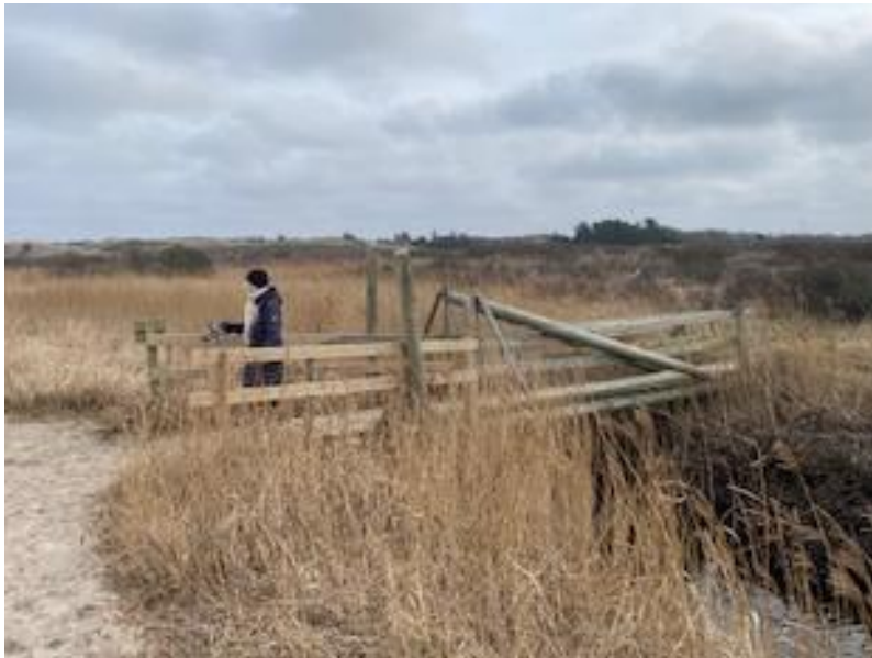
Fig. 6. Billede fra ansøgningen. Den eksisterende bro over Tversted Ås udløb.
