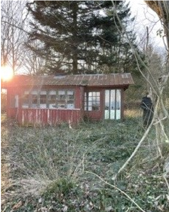
Foto af eksisterende østfacade (mod vandet). Udestuen ses i forgrunden
