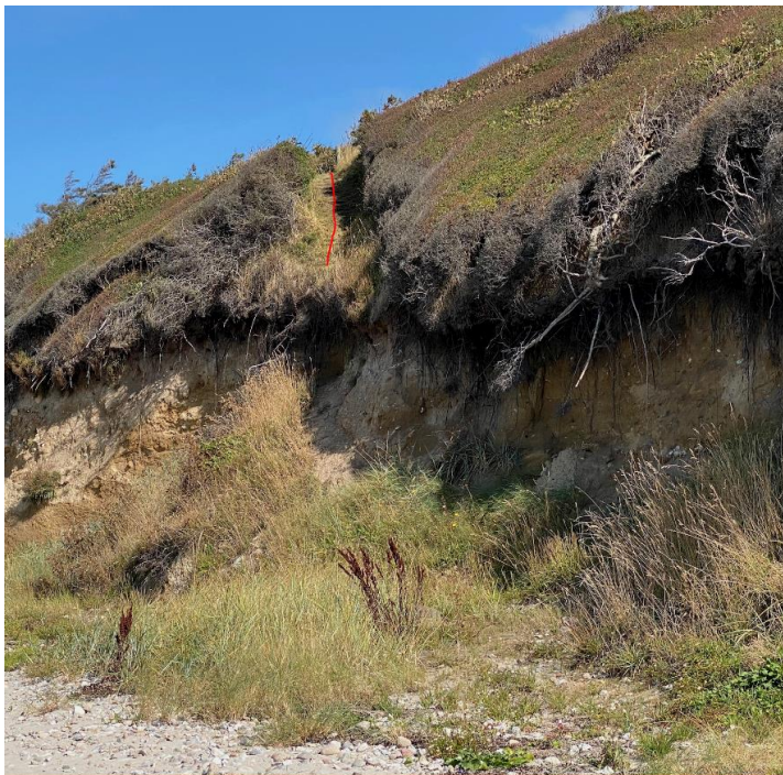
Eksisterende forhold 2021 – rød markeret stien i skrænten
