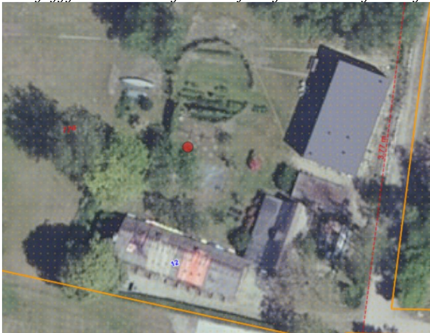
Ortofoto 2020. Det nybyggede hus ses øverst til højre – det oprindelige hus ses nederst til venstre
