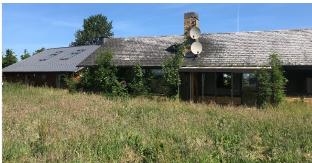
Eksisterende stuehus med 180 m 2 driftsbygning bag
