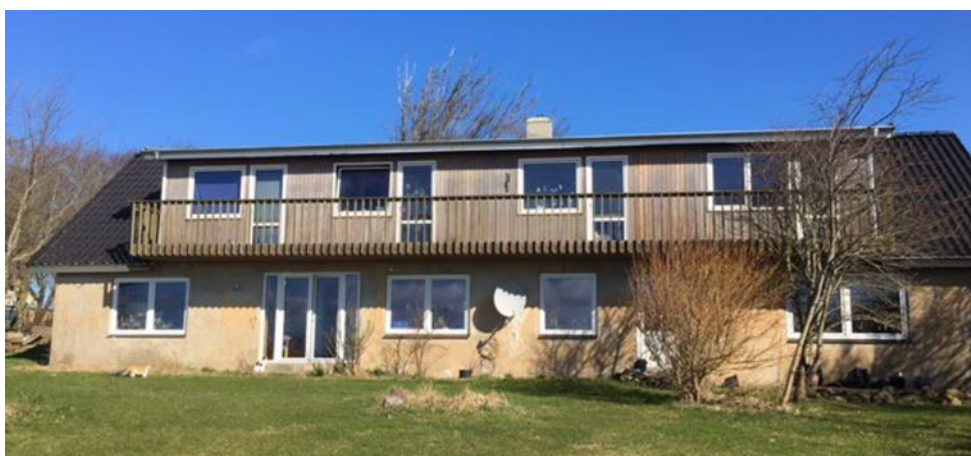
Eksisterende bolig med altan der fremtræder som overdækning
