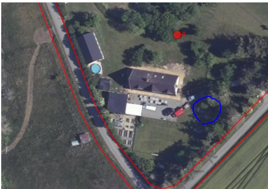
Figur 2, ejendommens bebyggelse på ortofoto 2020. Den ansøgte bygnings placering er markeret med blå streg
