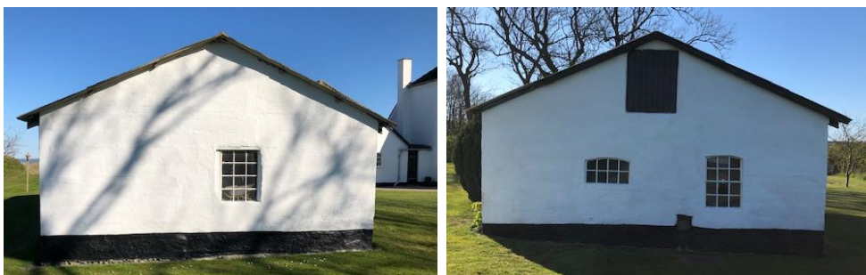
Fig. 3. Billeder fra ansøgningen af det eksisterende udhus. Til venstre ses facaden mod nordvest. Til højre ses facaden mod sydøst.
