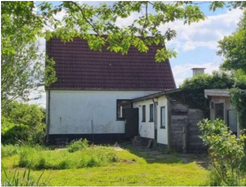
Facade mod nordøst. Eksisterende vindue ændres til dør i samme bredde som vindue. Døren bruges som ny hovedindgang. Der isættes dobbelt terrassedør til venstre for dør. Taget skiftes og der monteres to mindre pult kviste som på modsatte side. Facaden efterisoleres og beklædes med træ.
