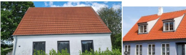
Facade mod Sydvest. Vinduer skiftes til tofags sidehængte vinduer som huset oprindeligt har haft, i samme størrelse som eksisterende. Facaden efterisoleres og beklædes med træ. Taget skiftes og der monteres to mindre pult kviste i stil med billedet til højre.
