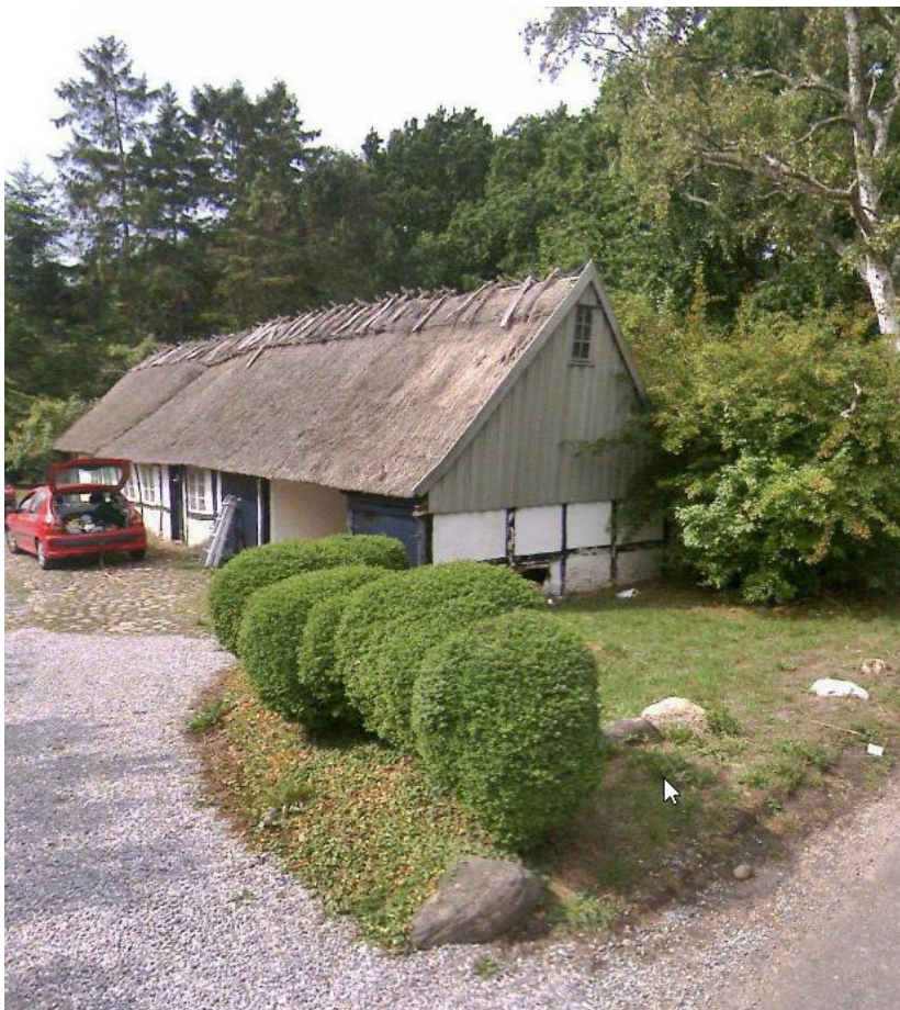
Foto af den eksisterende bygning.
