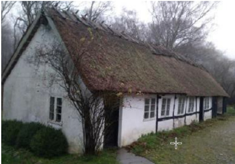
Foto af den eksisterende bygning.
