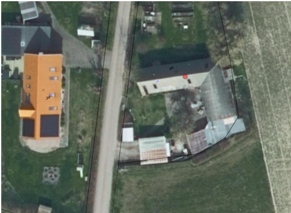
Luftfoto af ejendommen og naboen mod vest. Det fremgår, at der er opsat solceller på taget af naboejendommen mod vest.
